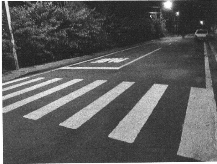
Acervo Pessoal – Verificação dos finalmente do Asfalto ao Lado da ASSEMUR
