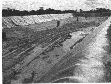
Acervo Pessoal – Visita ao Aterro Sanitário
