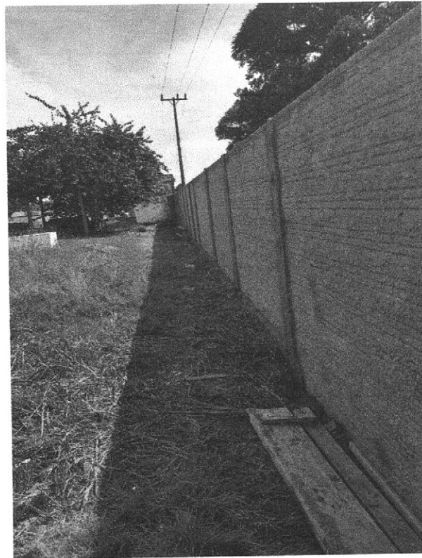
Acervo Pessoal – Verificação dos finalmente do Muro em Volta do Cemitério
